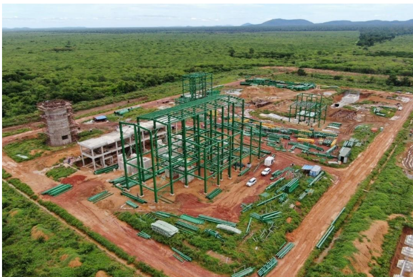
Figura 87. Construcción de la Planta Siderúrgica del Mutún. Fuente: Ministerio de Minería y Metalurgia
